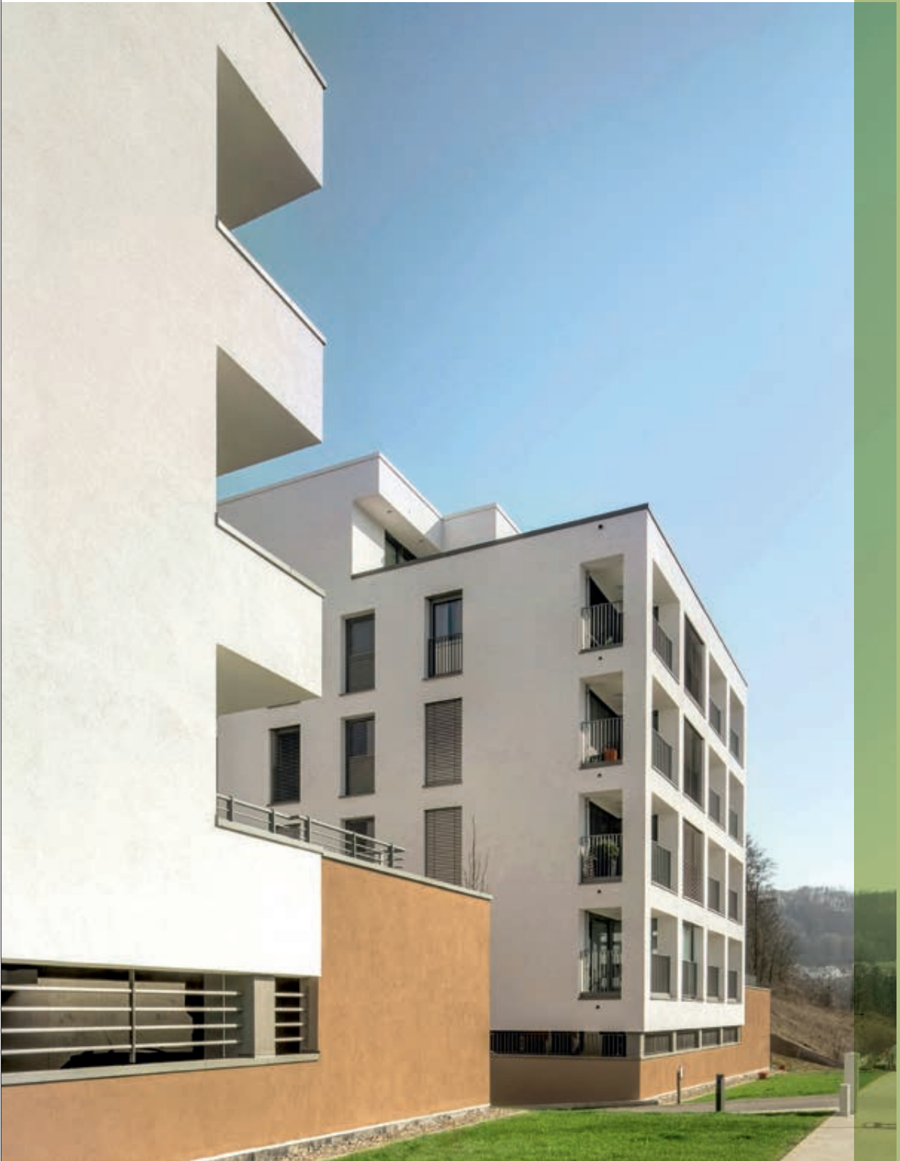
GREEN HILL Luxemburg Stad (Dommeldange) CBA - Christian Bauer & Associés Architectes
